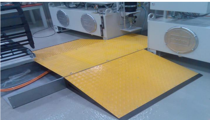
Rampen und trittfester Kabelkanal mit Alu-Riffelblechdeckel
